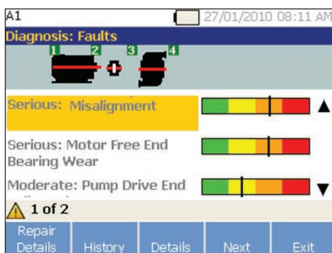
2. Diagnóstico y recomendaciones de reparación utilizando los instrumentos de medida de vibraciones de Fluke.
