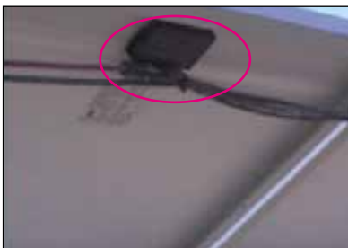
Caja de conexiones y diodos de protección
